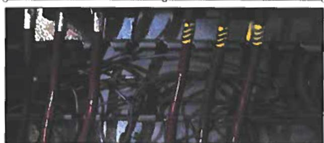
Для подтверждения правильности работы термоиндикатора произведен бесконтактный замер температуры тепловизором, при котором подтвержден нагрев контактов магнитного пускателя до 82°C.
